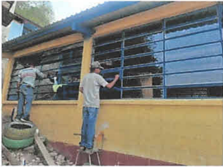
Foto 7: MANTENIMIENTO, PULIDO, LIJADO Y PINTADO DE ESTRUCTURA METÁLICA Y LIMPIEZA DE VIDRIO DE BALCONES.
