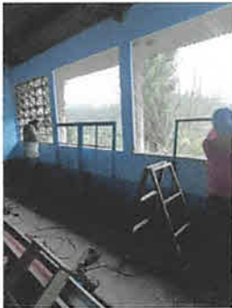
Foto 5: SUSTITUCIÓN DE VENTANA TRADICIONAL POR VENTANA ABATIBLE DE 1.45X1.80 M2.
