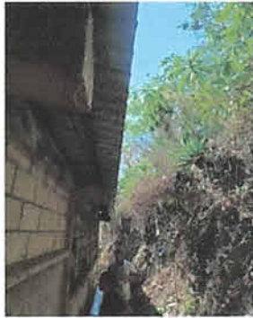
Foto 2: COLOCACION DE 22 ML DE CANAL ALUCIN.
