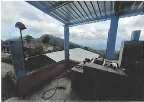
Foto1: SUSTITUCIÓN DE COCINA RURAL POR HORNILLA CON PLANCHA Y CHIMENEA.
